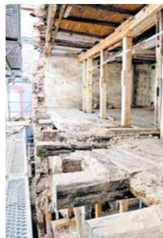
Eindrucksvoll: Im ersten Bauabschnitt wurden Teile der Südwand abgebrochen und fachgerecht wieder aufgebaut. Foto: Genossenschaft Haus zum Maulbeerbaum
